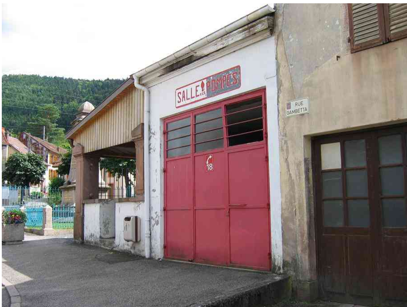
Allarmont. La Salle des Pompes
